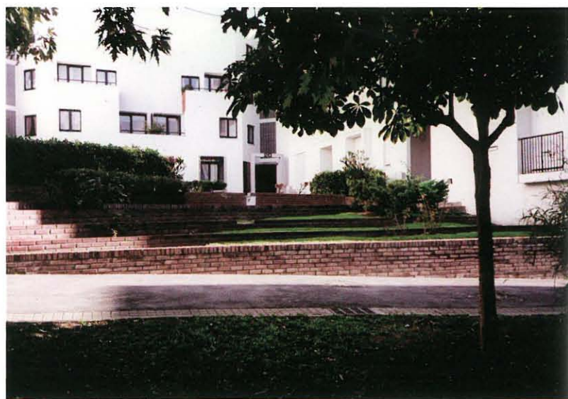
Îlot Carnot Stains, 1980, fond de cour.
